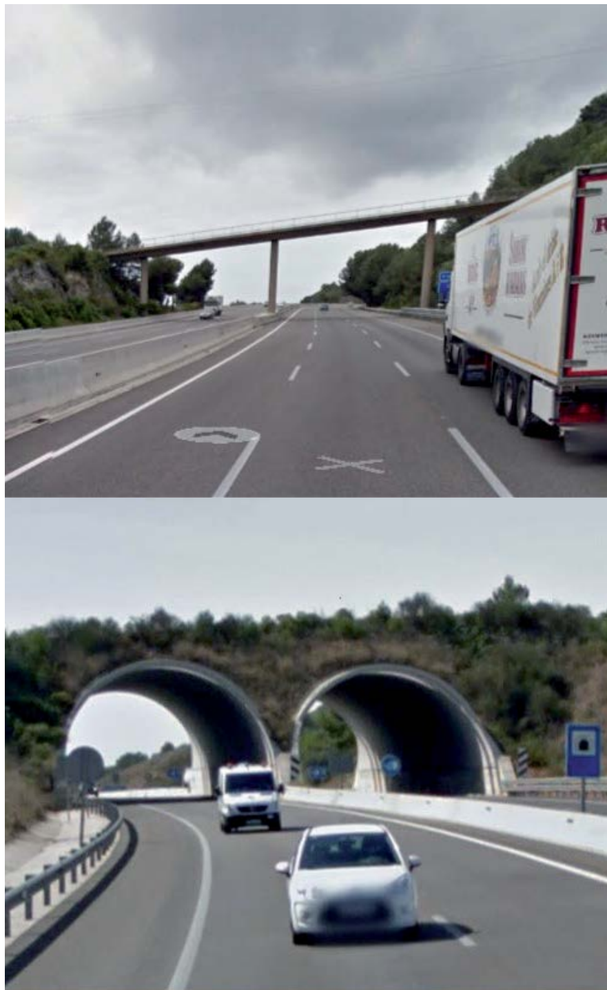
Autovía A-7. Paralelismo con la AP-7. Tarragona
