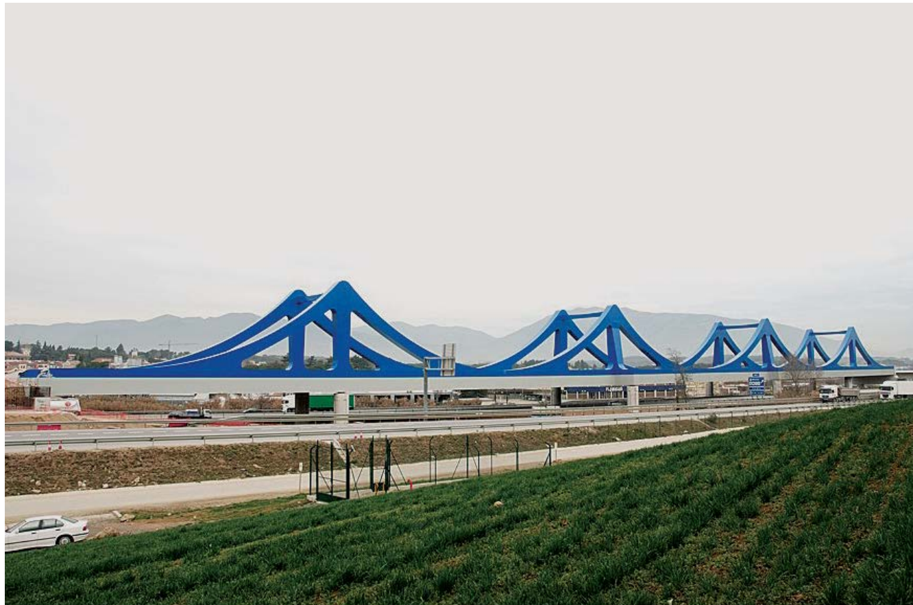
Viaducto para el AVE
